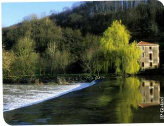
Ces obstacles à l'écoulement appelés seuils ou barrages, en fonction de leur hauteur, créent une chute d'eau permettant aux moulins d'utiliser la force de la rivière.
