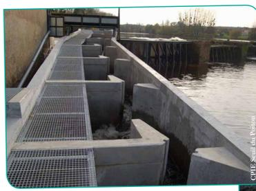
Quand l'ouvrage doit être maintenu pour des raisons socio-économiques voire écologiques, des mesures existent mais ne permettent pas toujours de répondre à l'ensemble des problèmes constatés : installation d'une passe à poissons (photo 1), création d'un bras de contournement (photo 2) et bonne gestion des vannages.
